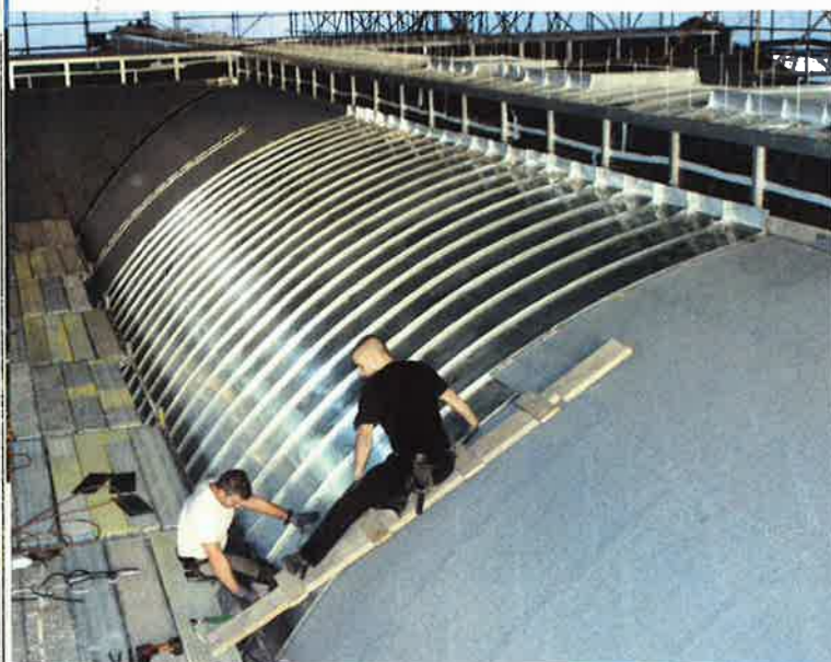
Die Dachdecker montieren die Zinkscharen
