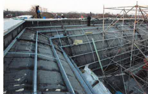
Das Tonnendach in seinem ursprünglichen Zustand vor der Dämmung und Eindeckung Fotos: Ragas Dachdeckermeisterbetrieb GmbH
