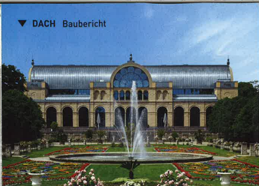
Die Flora ist das Hauptgebäude des Botanischen Gartens in Köln. Das Dach wurde komplett saniert Foto: Rheinzink
