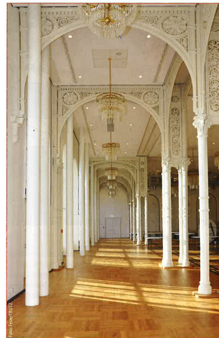
Abb. 2: Die filigranen Stützen aus Grauguss im großen Festsaal haben nach den Umbauarbeiten keine tragende Funktion mehr.
