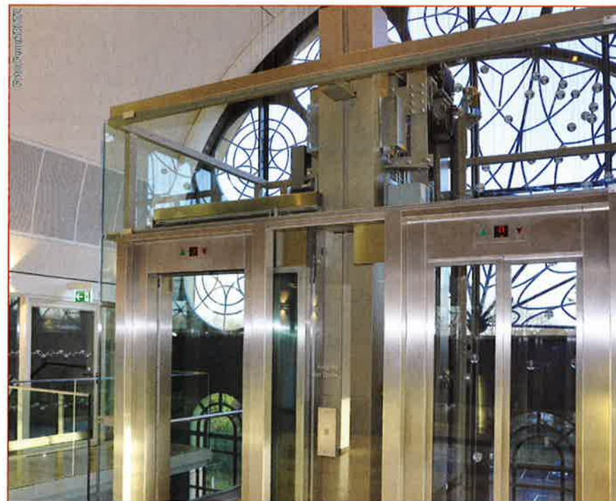
Abb. 4: Das Foyer mit freier Aufzugsanlage und Natursteinstegen zu den Treppenträumen ist zu anderen Nutzungen und Räumen feuerbeständig abgetrennt.
