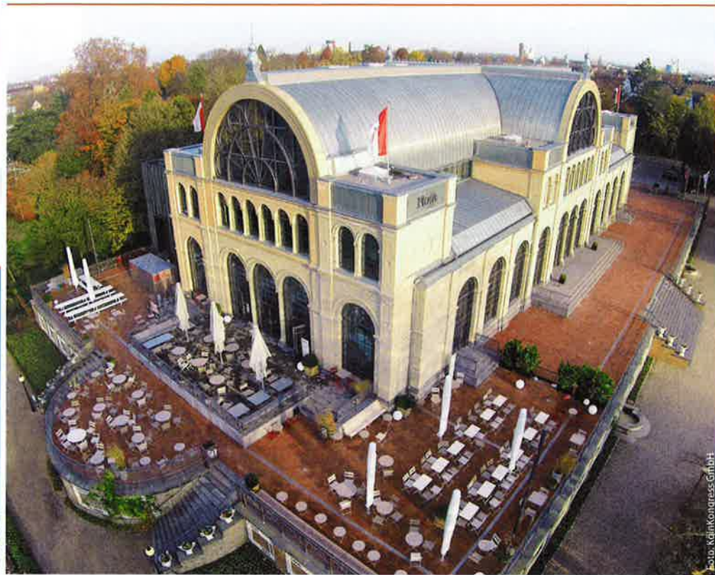
Abb. 7: Die Ergebnisse einer EDV-gestützten Evakuierungsberechnung führten zu Vorgaben für die Gastronomie auf der Terrasse vor den Ausgängen.
