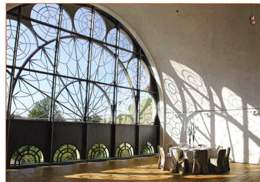
Abb. 3: Die Obergeschosse sind über notwendige Treppen in den vier markanten Ecktürmen erreichbar. Hier der imposante Dachsalon unter dem Tonnendach.
