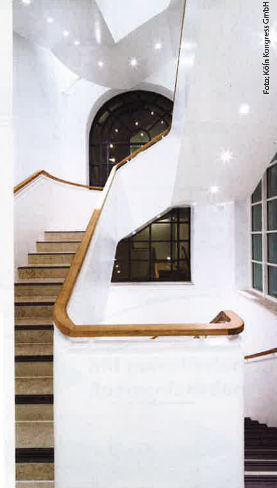
Um die nutzbare Breite der Bestandstrepfen nicht zu verringern, ließen die Bauherren die Handläufe auf das Geländer aufsetzen.
