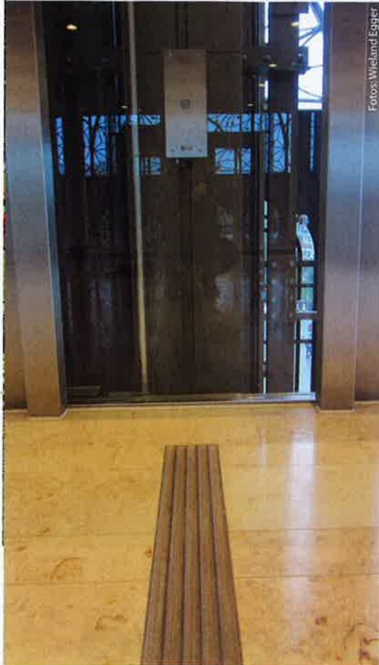
Das Leitsystem, bestehend aus auch visuell erkennbaren, taktilen Elementen und eingefrästen Aufmerksamkeitsfeldern, leitet die Besucher durch das Gebäude.
