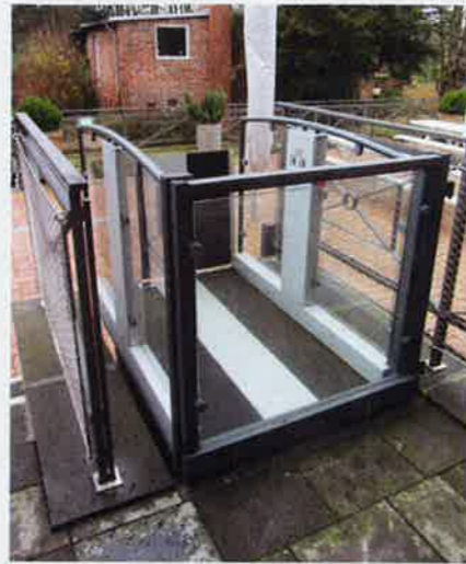
Ein kleiner Hublift hilft bei der Überwindung des Niveauunterschieds der beiden Ebenen auf den Caféterrassen.
