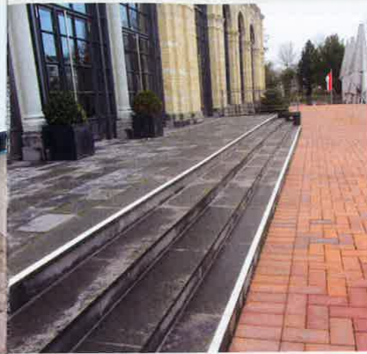
Die Außentreppen sind vom Terrassenbelag farblich abgesetzt, die An- und Austrittsstufe zusätzlich durch weiße Markierungen gekennzeichnet.
