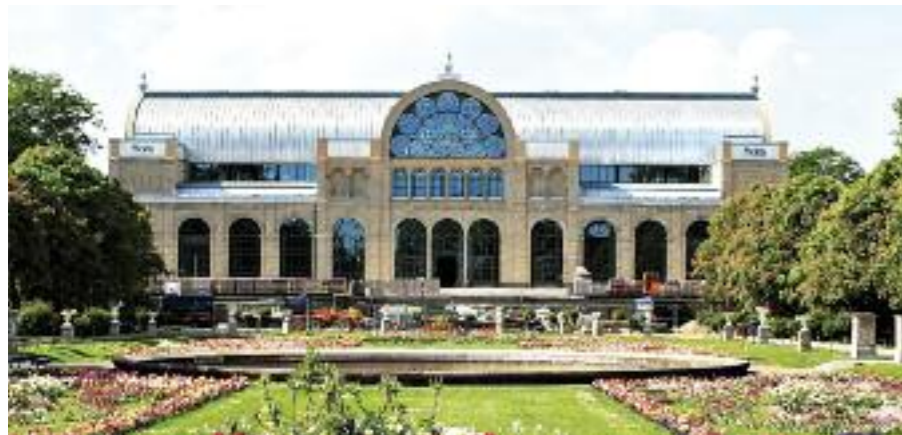
Die Flora mit neuem Tonnendach
