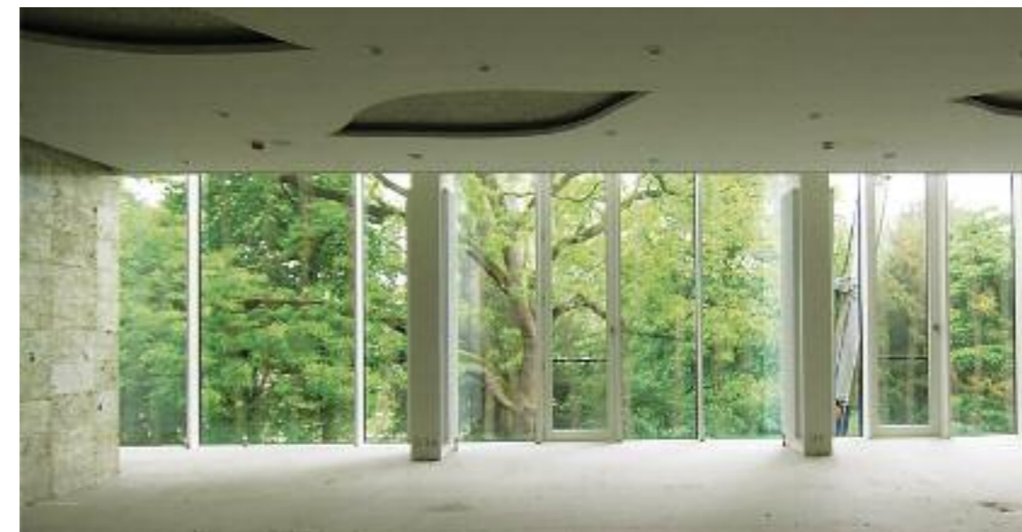
Auch der Rohbau bietet bereits einen reizvollen Blick in den Garten
