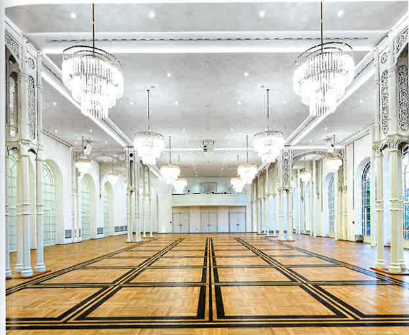
Großer Saal: aufgearbeitete Gussstützen und Lüster • Large hall: Reconstructed cast-iron supports and lusters
