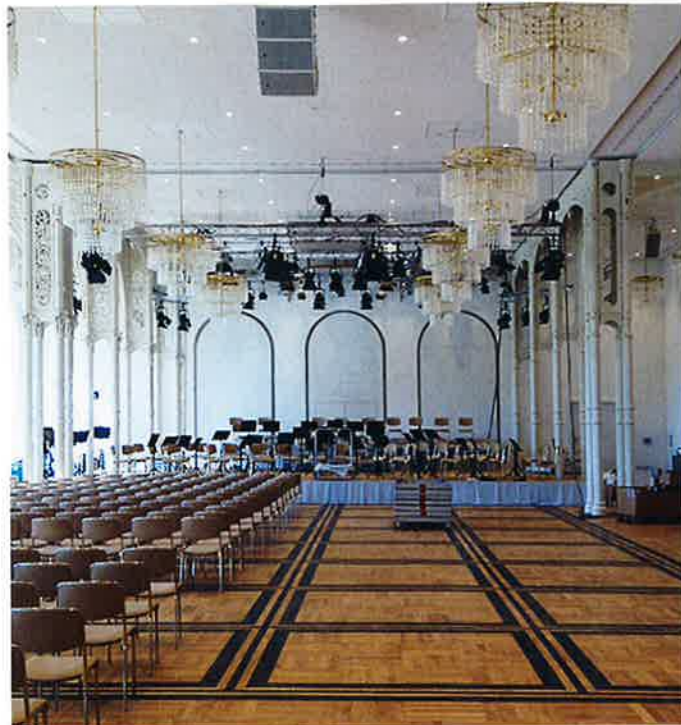
Absorptionsfläche gesucht. An der Stirnseite wurden drei bereits vorhandene Rundbögen mit einer Holzkonstruktion ausgestattet, deren Oberfläche mit akustisch wirksamer Lochung versehen ist.
