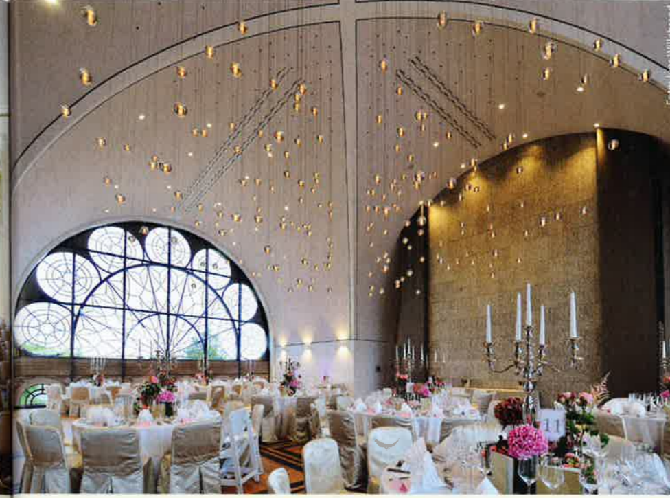
Akustikprobleme. Kuppeln sind aus akustischer Sicht immer schwierig. Angesichts vieler schallharter Flächen im Saal (Stein an den Wänden und große Verglasungen) musste die Kuppel selbst absorptiv ausgelegt werden.
